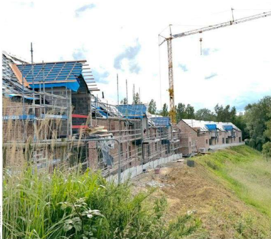
Vingt-deux logements sont en cours de construction rue de Ghelderode à Louvain-la-Neuve.
